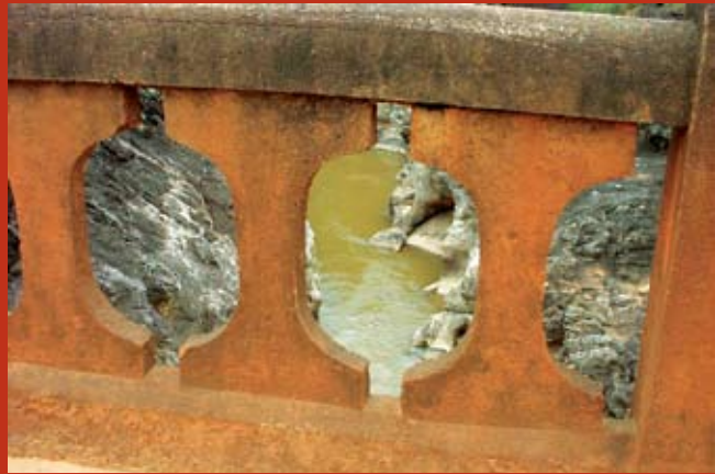
PONTE DO VAU, SOBRE O JEQUITINHONHA FOTO: ACERVO TERRAZUL
