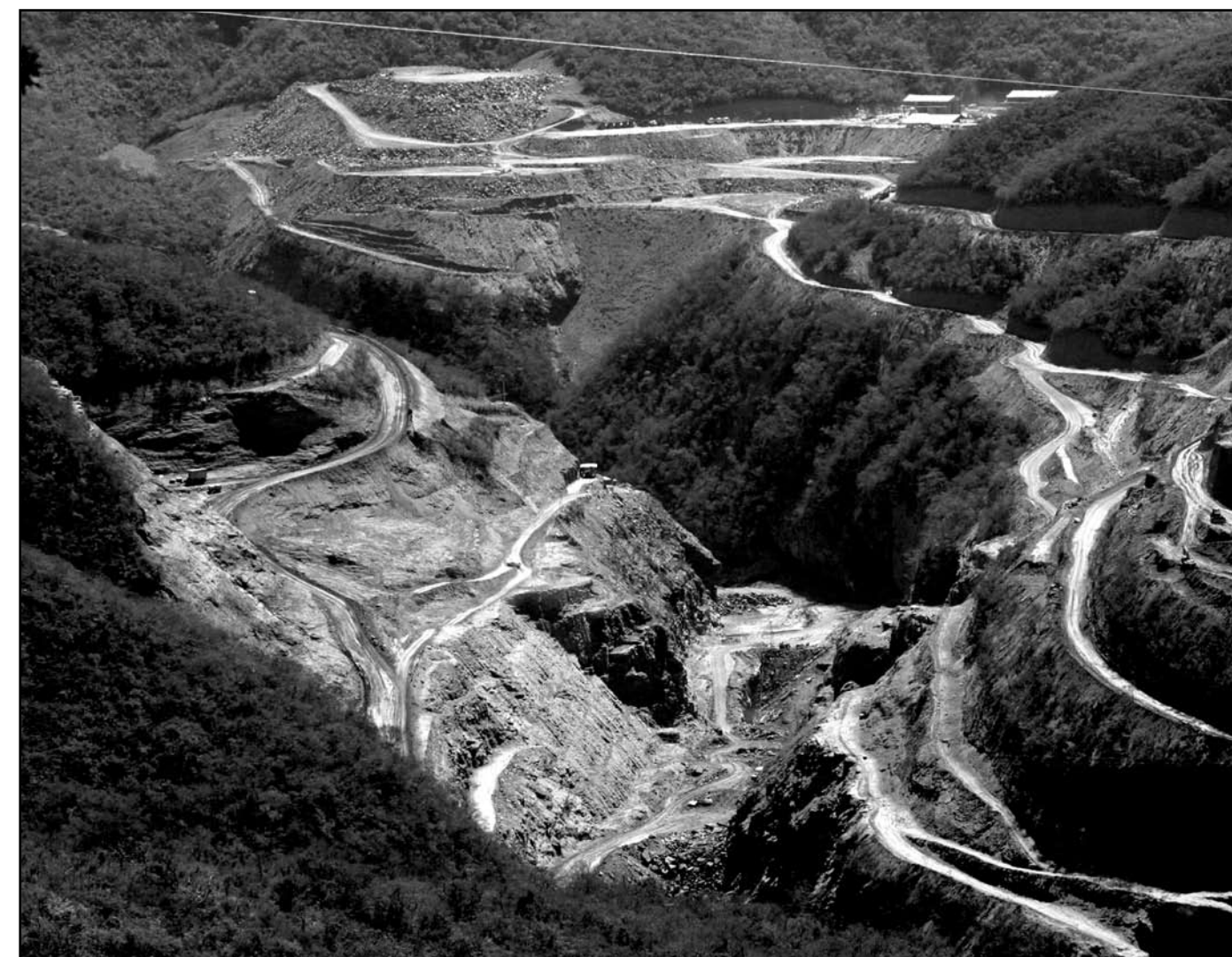
OBRAS DA USINA DE IRAPÉ, UM INVESTIMENTO DE R$ 1 BILHÃO
