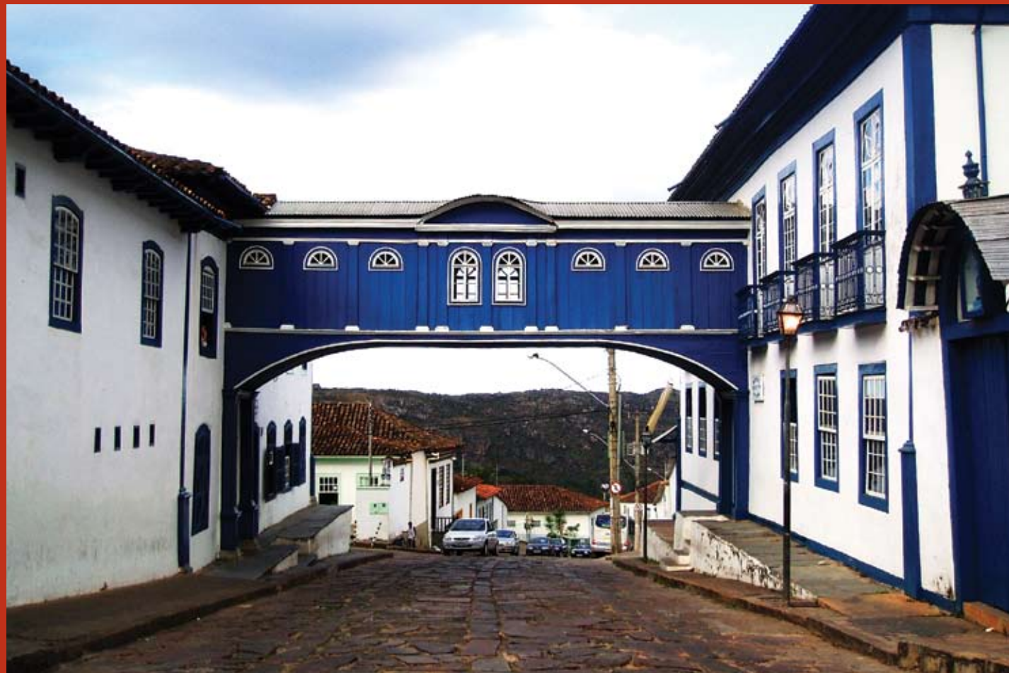
PASSADIÇO DO CONJUNTO DA GLÓRIA, EM DIAMANTINA FOTO: BUENO DO PRADO/TERRAZUL
